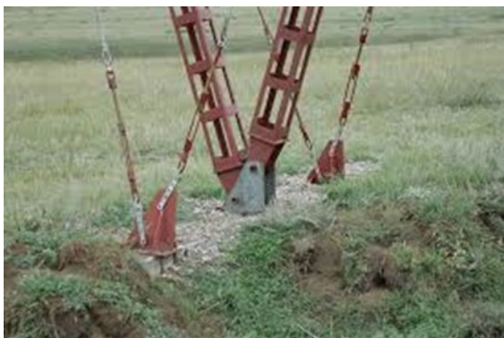
Фиг. 4.9 Повърхностен фундамент
