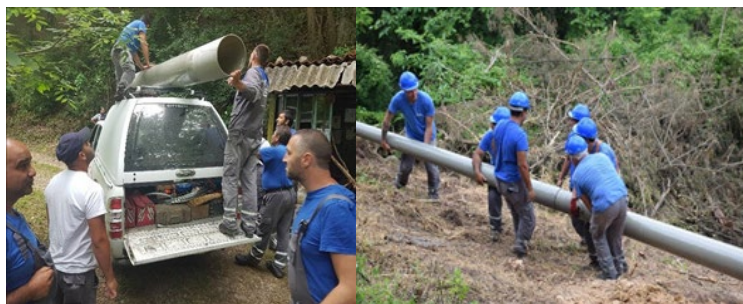
фиг.4.12 Полимерен модулен стълб 20 кV
