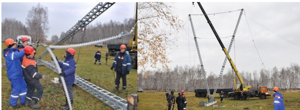
Фиг. 4.10. Монтаж на стълб с полимерни конзоли
