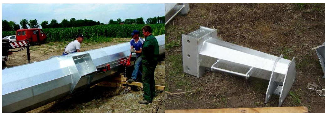
Фиг. 4.2 Монтаж на конзоли
