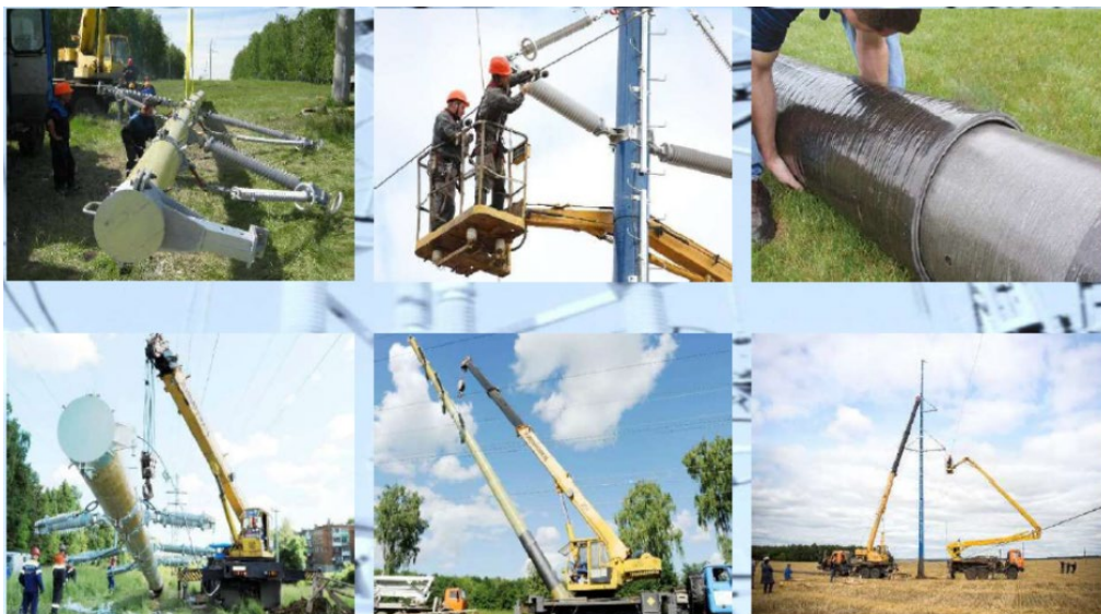
Фиг. 4.23 Монтаж на композитен стълб 110 кВ
