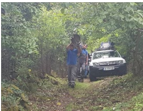
Фиг.4.17 Транспортиране на полимерен стълб на ръка
