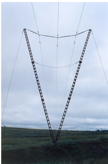
Фиг.4.9 Стоманен стълб на обтяжки с въжана конзола от полимерни (силиконови) изолатори
