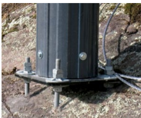
фиг. 4.11 Монтаж на стълб без фундамент
