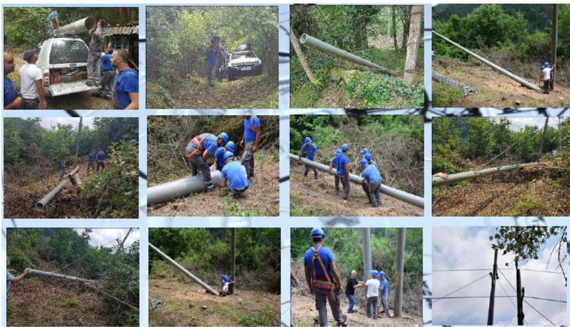
Фиг. 4.22 Транспортиране, монтаж на елемент и изправяне на композитен стълб 24 kV
