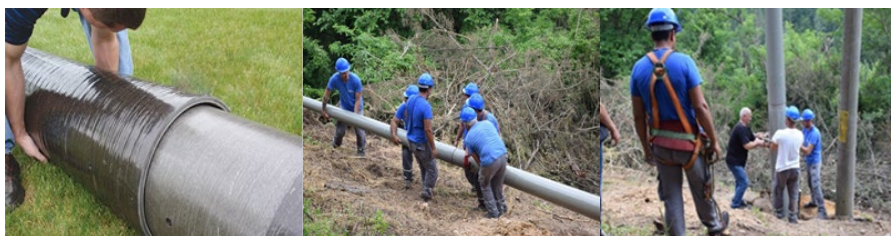
Фиг.4.18 Монтаж на модулен полимерен стълб
